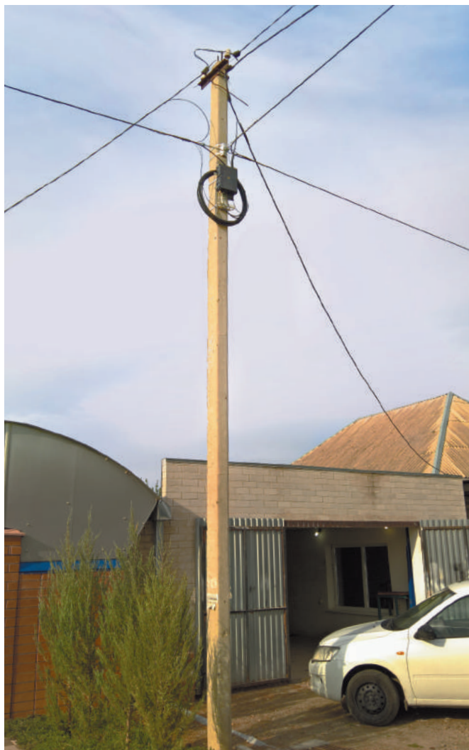
Рис.4. Дроп-муфта на 16 портов и навивные жгуты, один из отводов – по СИП (Краснодарский край, Усть-Лабинск)
