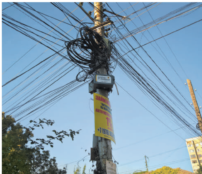
Рис.6. FTTH: кабельная вакханалия – лишь малая часть кабелей – рабочая (Симферополь)
