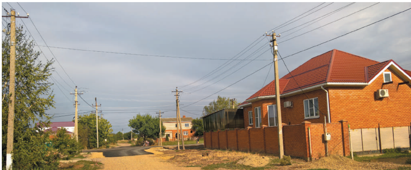
Рис.5. Отводы на тросах от навивного жгута – красивая "невидимая" сеть ФТТН (Краснодарский край, Усть-Лабинск)
